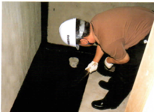
(화장실 조인트 보강방수)
